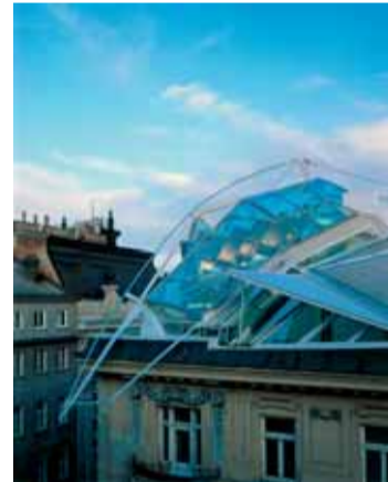
Rooftop Remodelling Falkestrasse, Vienna, Austria.
